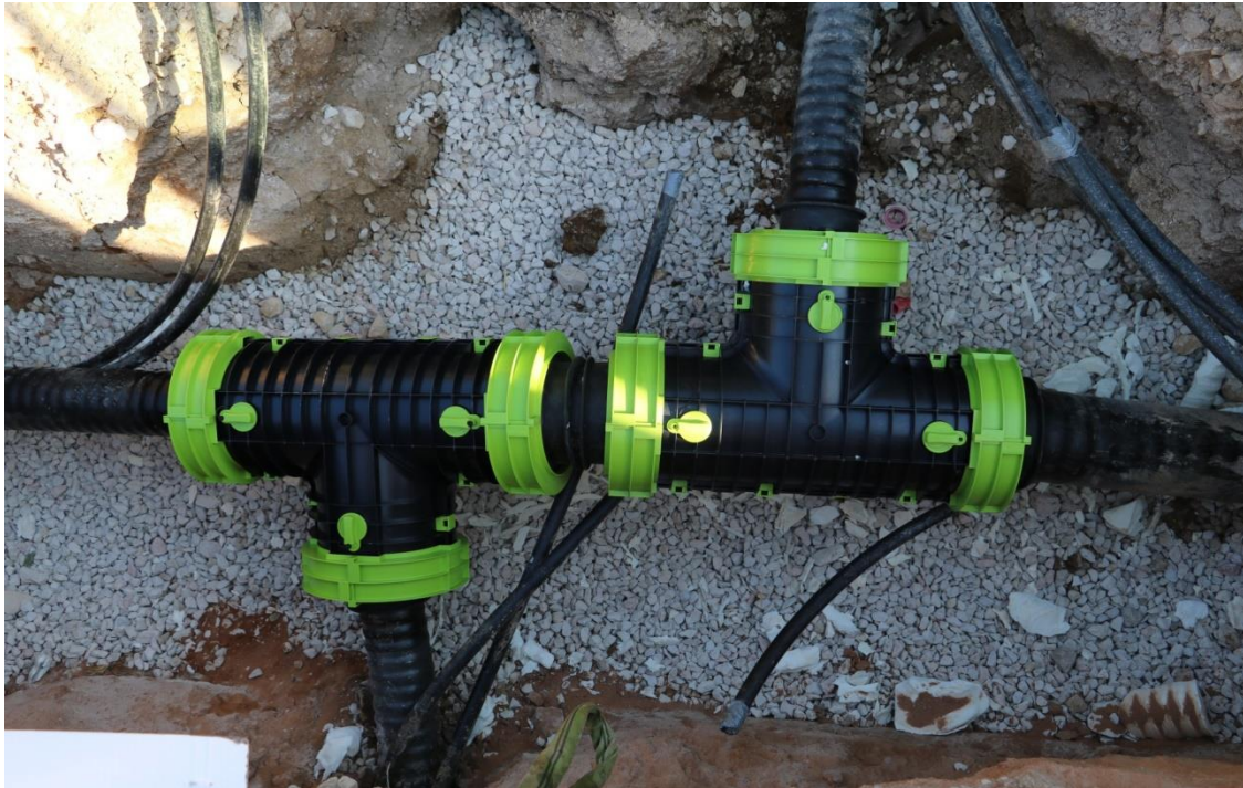
T-Stück im offenen Graben
